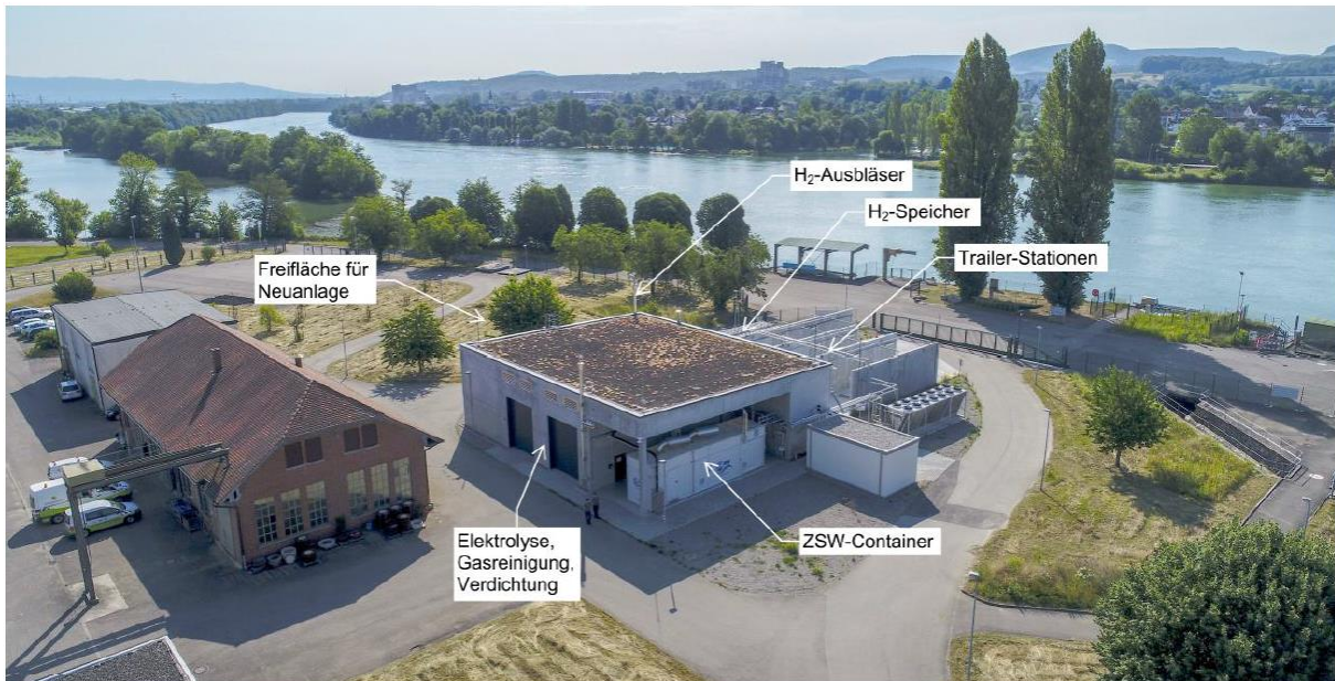
Abbildung 6: Blick nach Südosten auf die Bestandsanlage mit der dahinter liegenden Freifläche für die Neuanlage (Quelle: Unterlagen [b])
