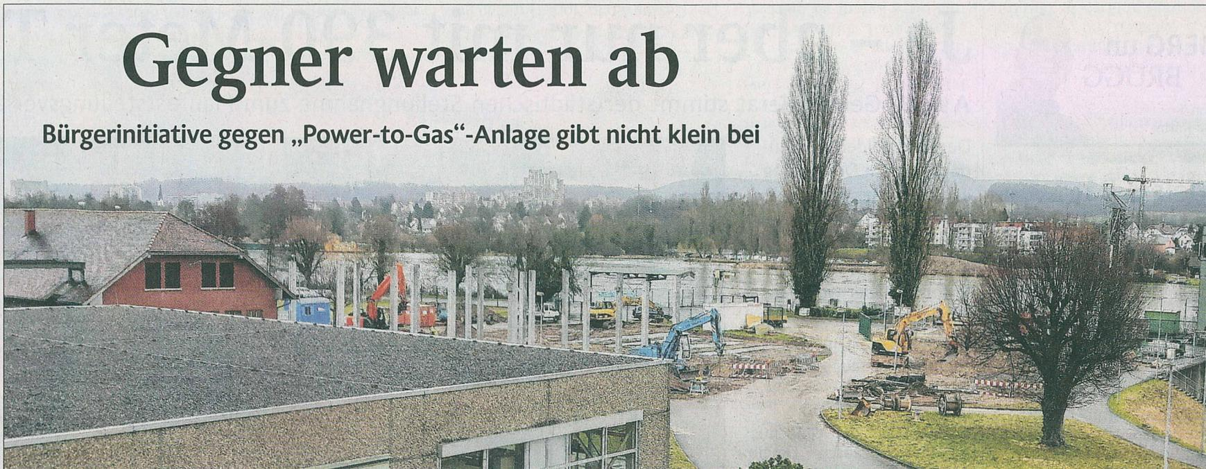
Zwischen den Gebäuden des Wasserkraftwerkes Wyhlen wachsen bereits tragende Betonelemente für die neue Halle in die Höhe, in der die Wasserstoff-Erzeugungsanlage zum Jahresende in Betrieb gehen soll.
